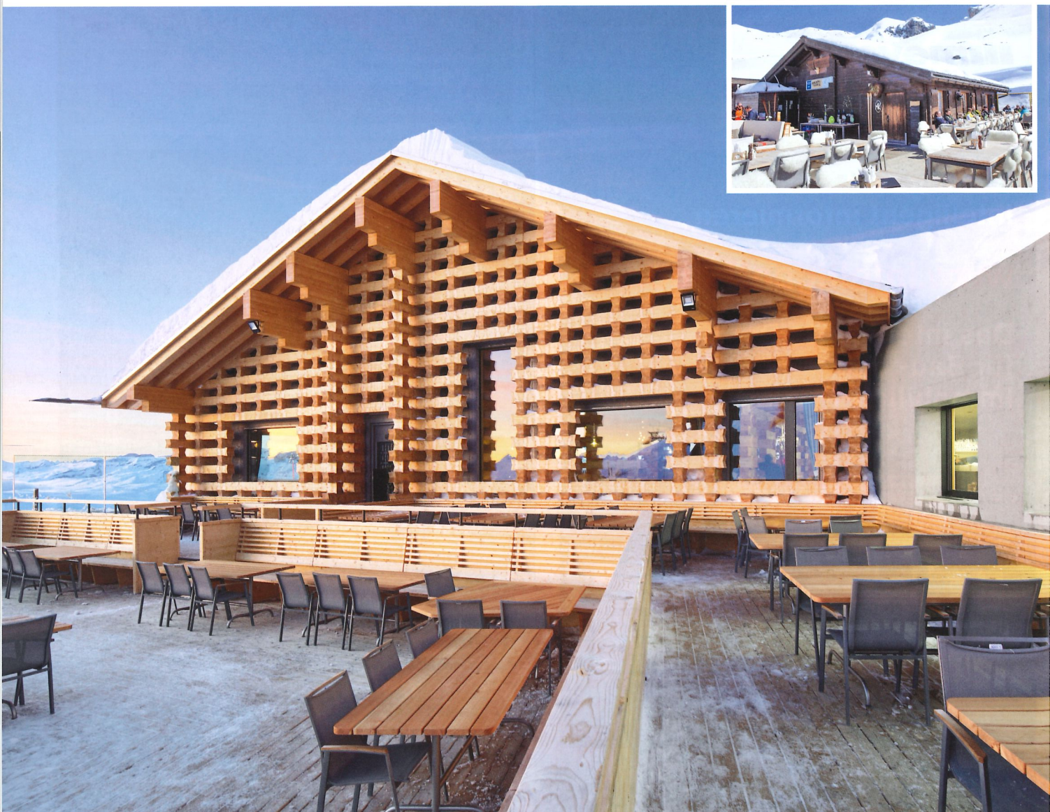
Vorher/nachher: Die Baulinie der ursprünglichen Motta-Hütte ist erhalten geblieben. Dabei wurde sie neu aufgebaut und mit einem seitlichen Baukörper ergänzt.
